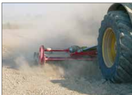
Travaux en condition extrême.
